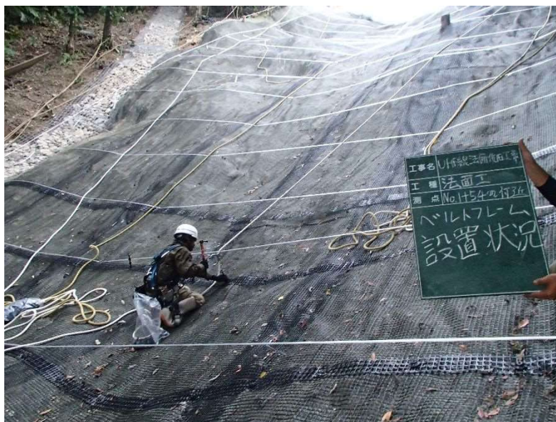
写真-6 ベルトフレーム設置状況
