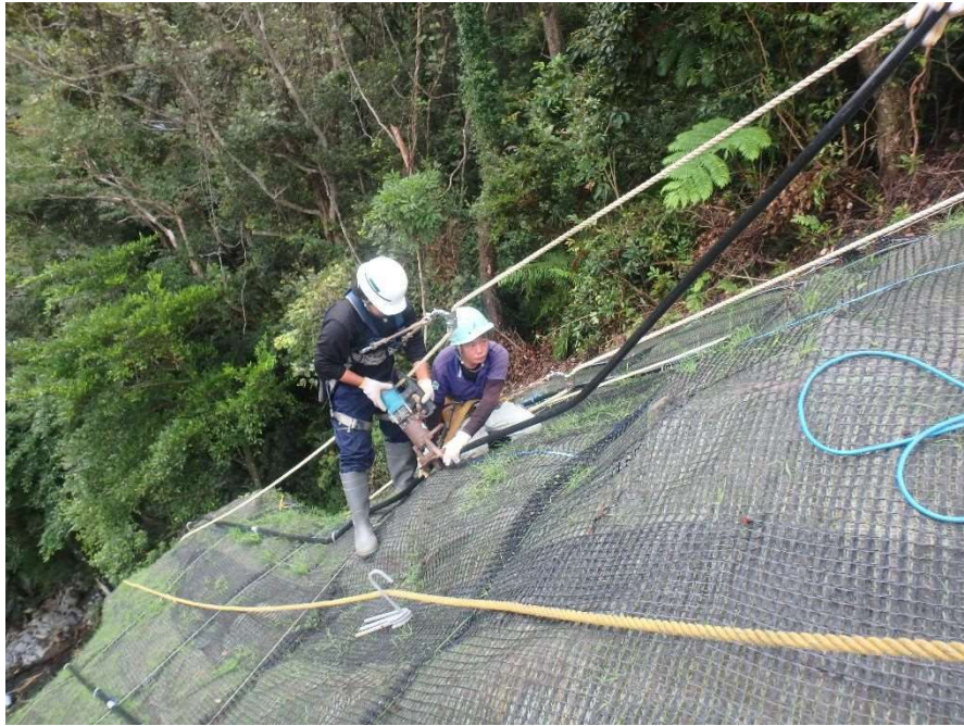
写真-12 ホールディングバー曲げ加工状況
