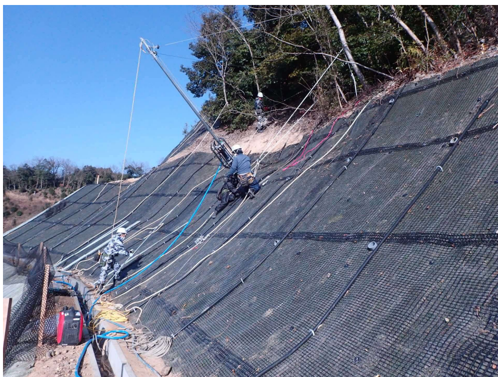
写真-18 ウインチ使用 人力移動での鉄筋打込み作業状況
