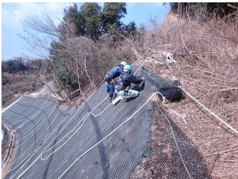
写真-7 ベルトフレーム設置状況
