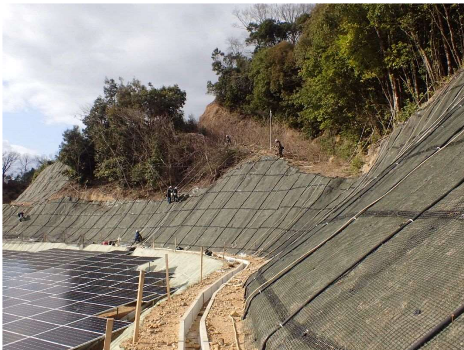
写真-20 ウインチ使用 人力移動での鉄筋打込み作業状況
