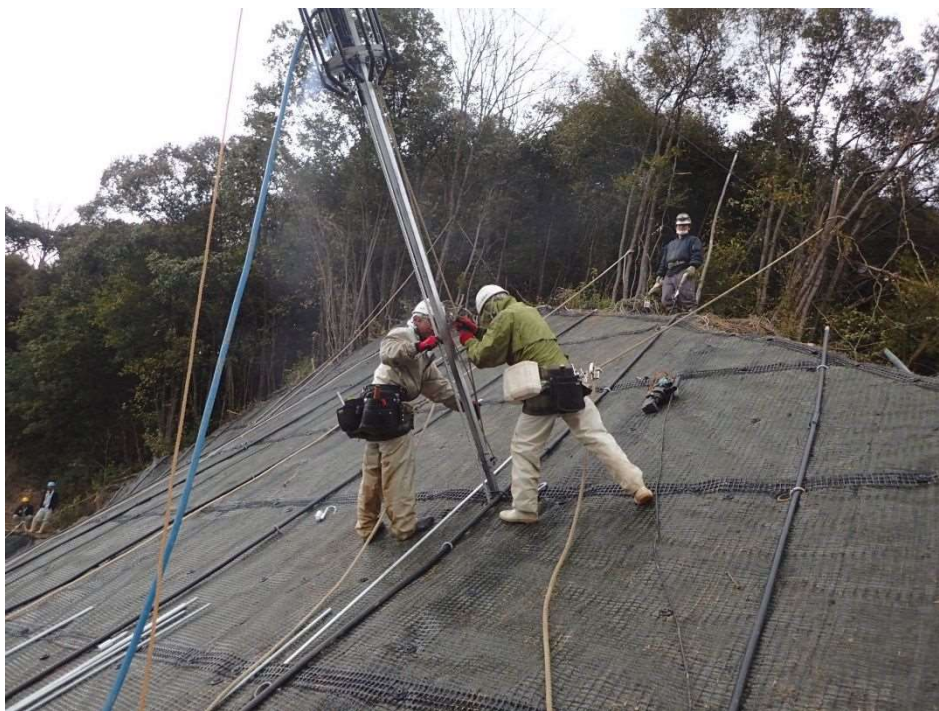
写真-19 ウインチ使用 人力移動での鉄筋打込み作業状況
