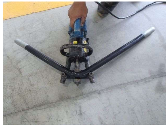
写真-14 D19 鉄筋曲機による曲げ状 況
