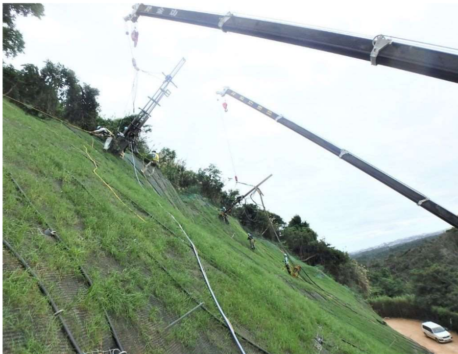
写真-15 クレーン吊り下げでの鉄筋打込み作業
