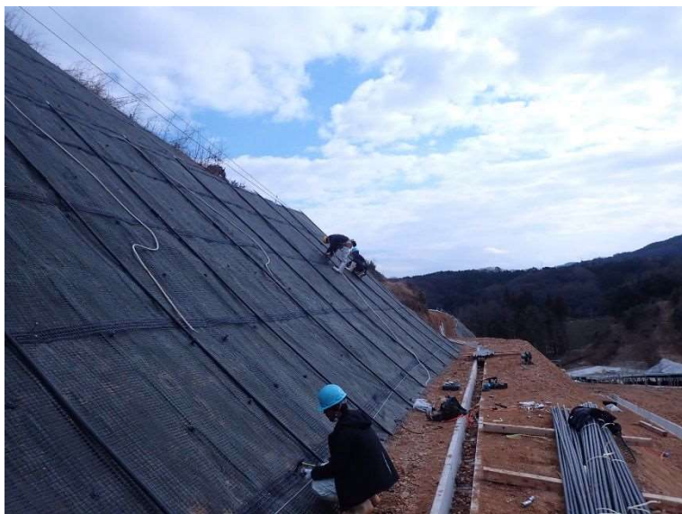
写真-10 ホールディングバー設置状況(曲げ加工少ない場合)
