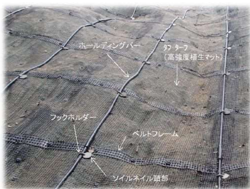
写真-1 フィット筋工法部材名称
