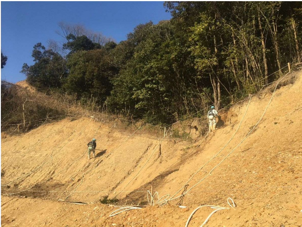
写真-2 法面整形
