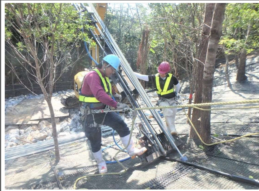
鉄筋挿入状況
