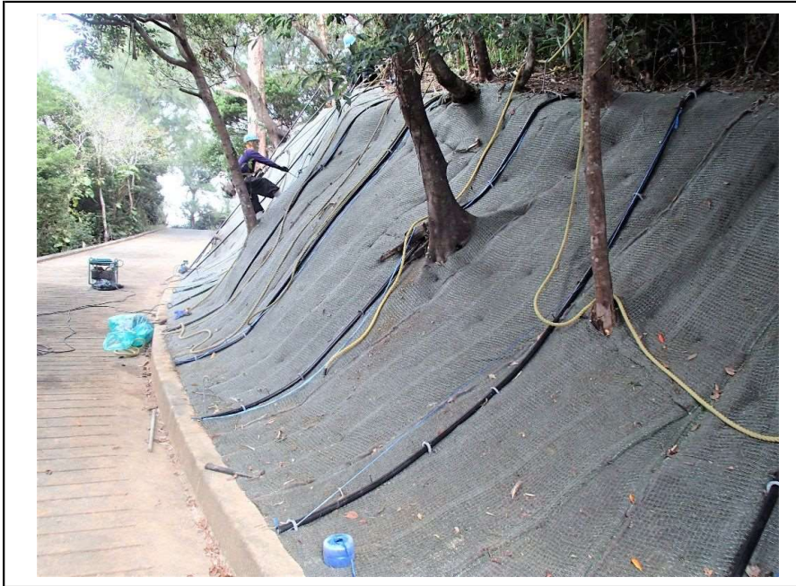
残木施工状況
