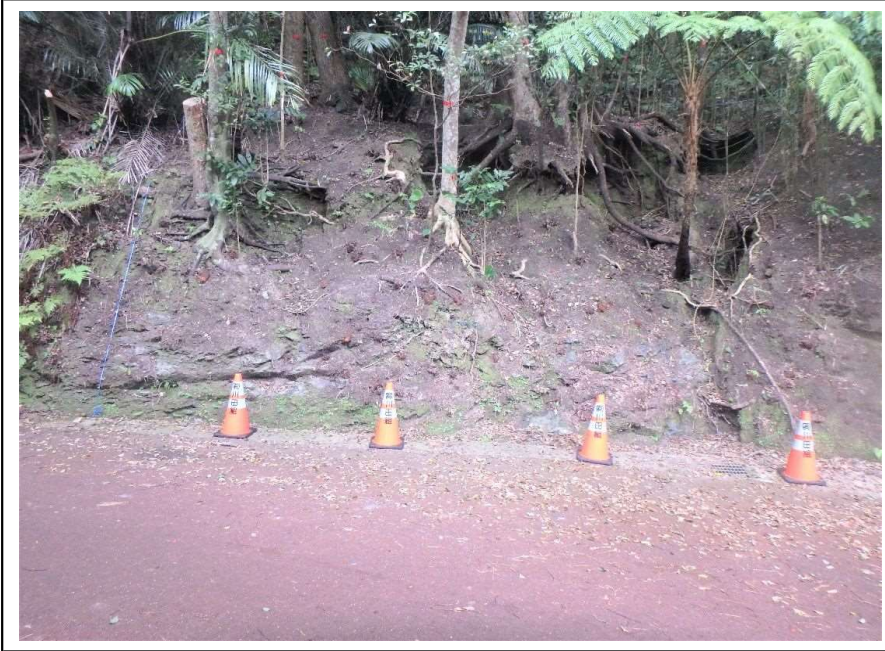
のり面整形状況
