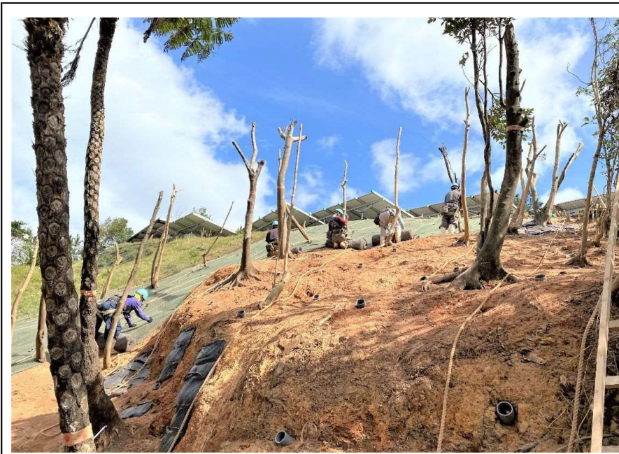
高強度植生マット敷設
