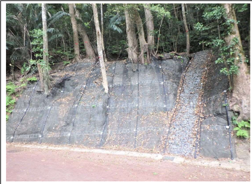
既存樹木根下 フィット筋工による補強
