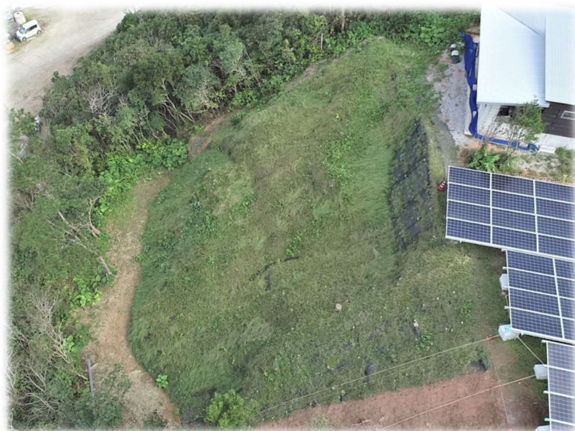
『フィット筋工法』で対策、竣工5か月後の緑化状況
