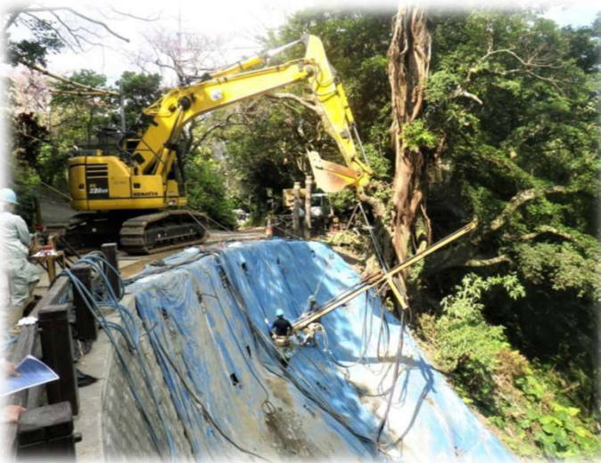
鉄筋挿入(削孔注入)
