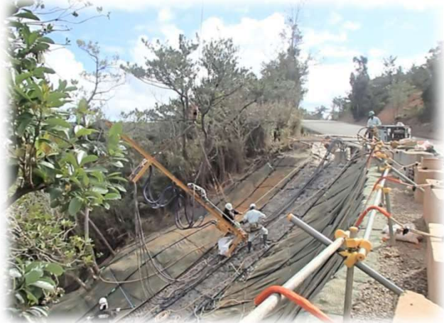
ソイルネイル(直打鉄筋挿入)
