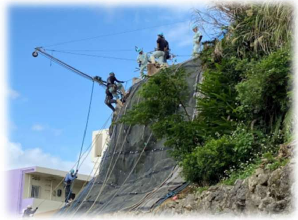
ウインチ使用人力施工
