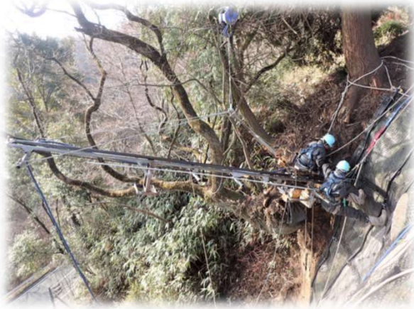
小型移動式クレーン使用
