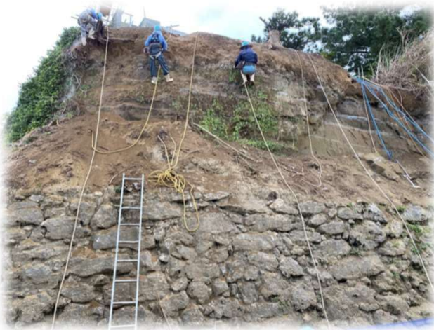
ソイルネイル(直打鉄筋挿入)
