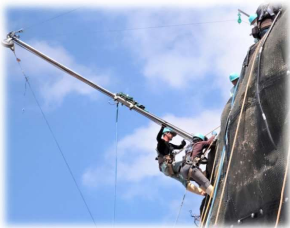
ソイルネイル(直打鉄筋挿入)
