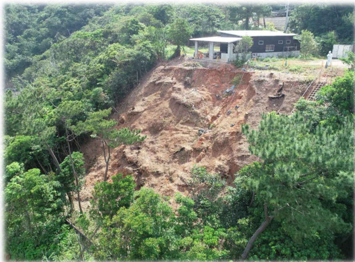
台風で崩壊した斜面
