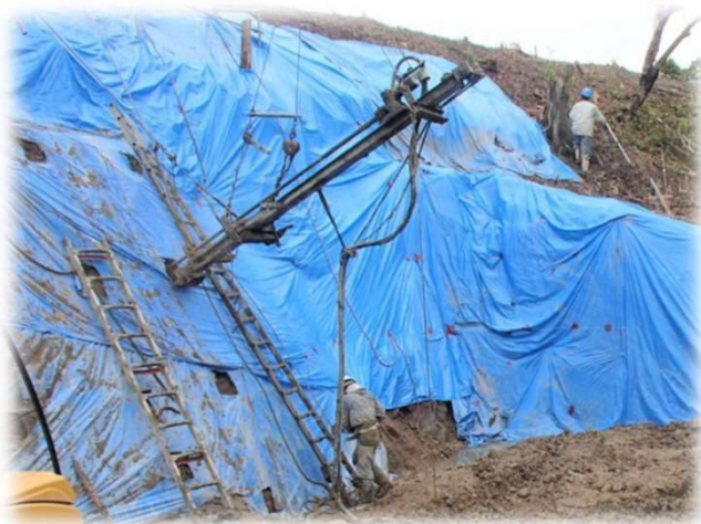
鉄筋挿入工
