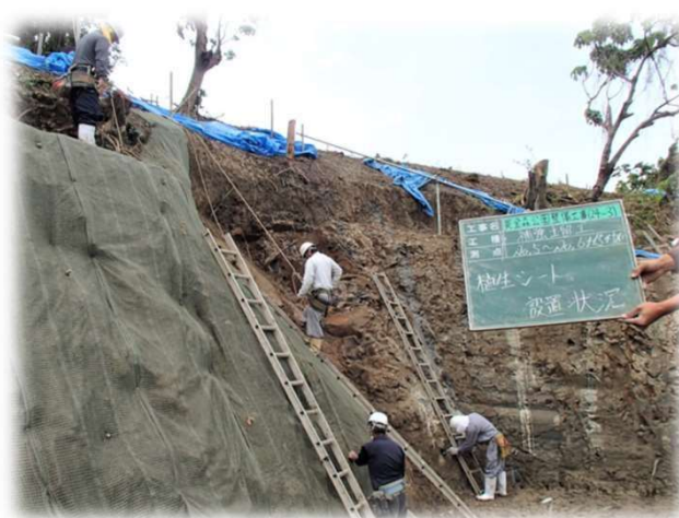
高強度植生マット設置
